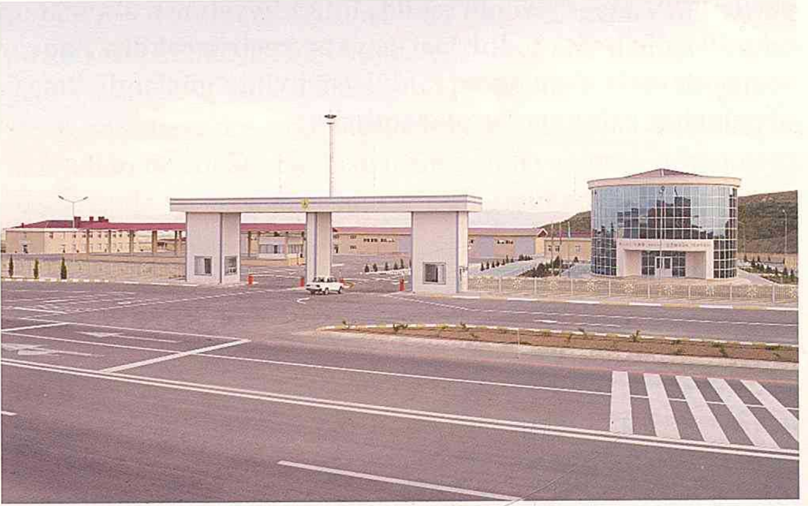
Naxçıvan Şəhər Gömrük İdarəsinin inzibati binası və köməkçi infrastrukturuları
