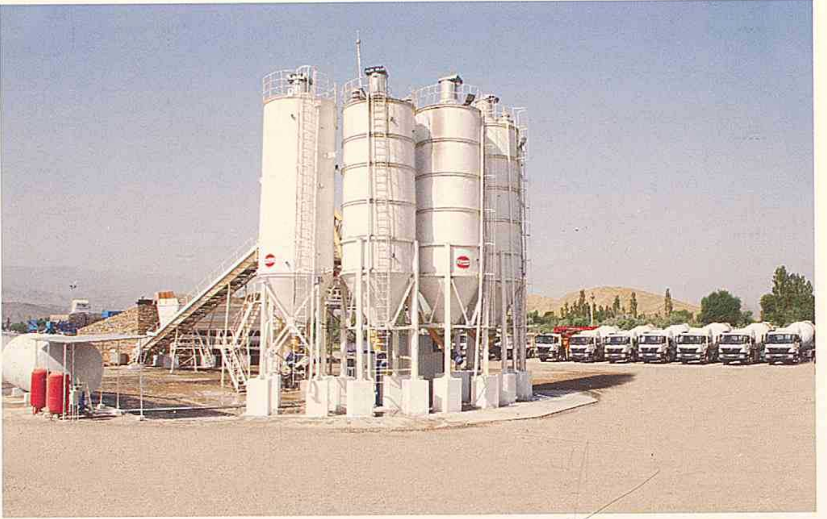
Ordubad rayonunun Aza kəndində Beton Zavodu və Qum-Çınqıl Karxanası
