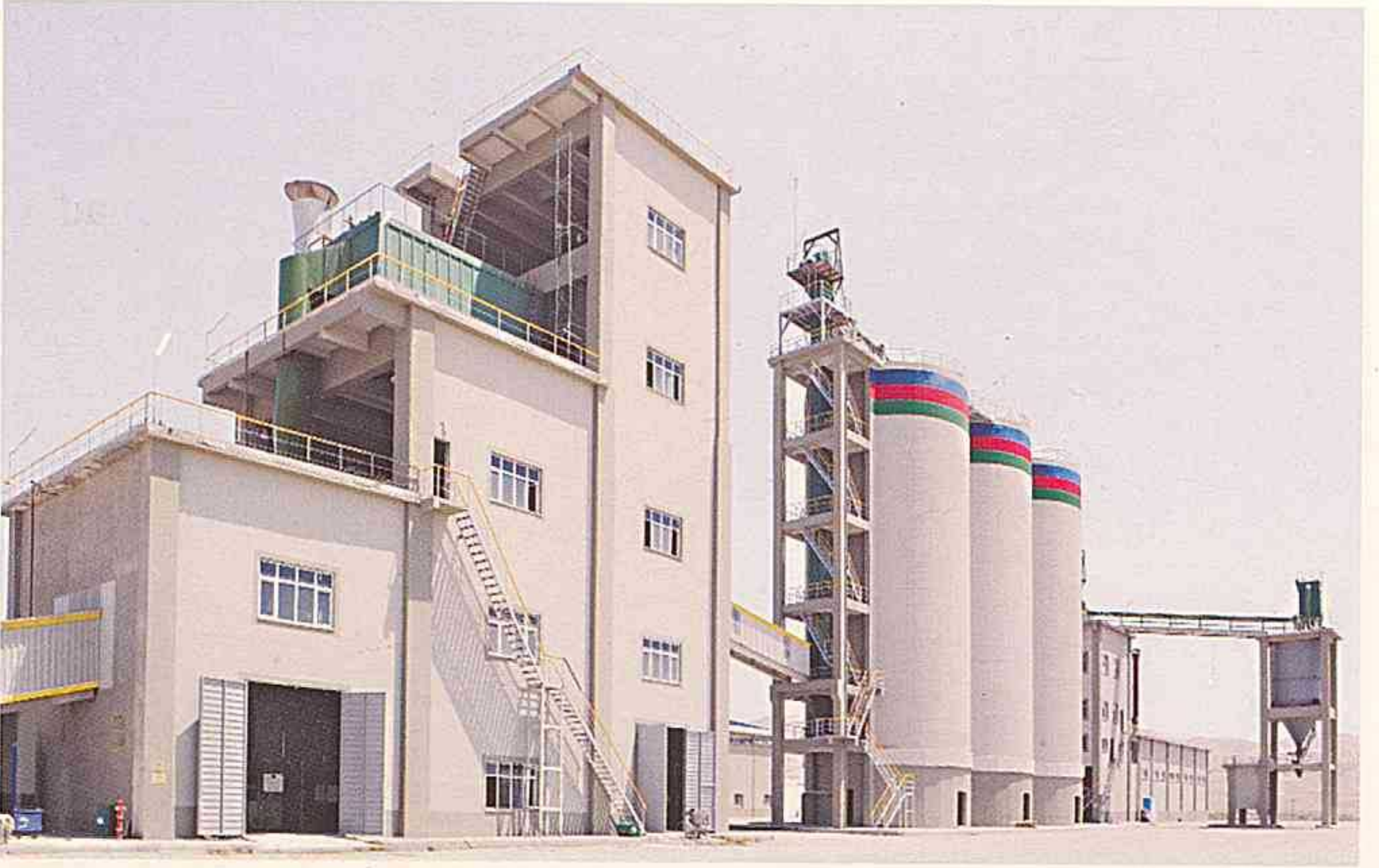
Kəngərli rayonunda Gəmiqaya Holding Şirkətlər İttifaqının sement istehsalı zavodu
