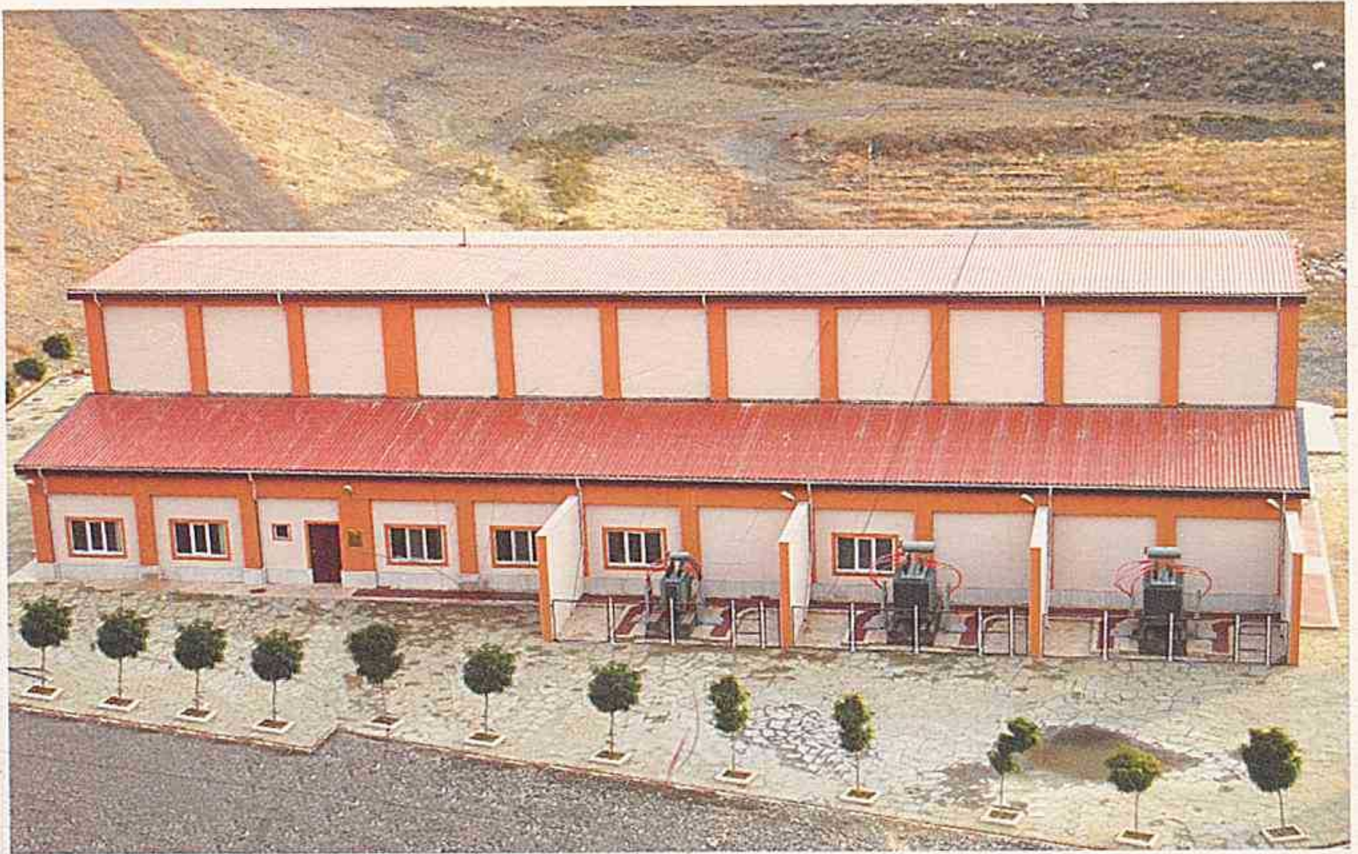
Şahbuz rayonunda Heydər Əliyev Su Anbarı üzərində ümumi gücü 4,5 meqavat olan Su Elektrik Stansiyası
