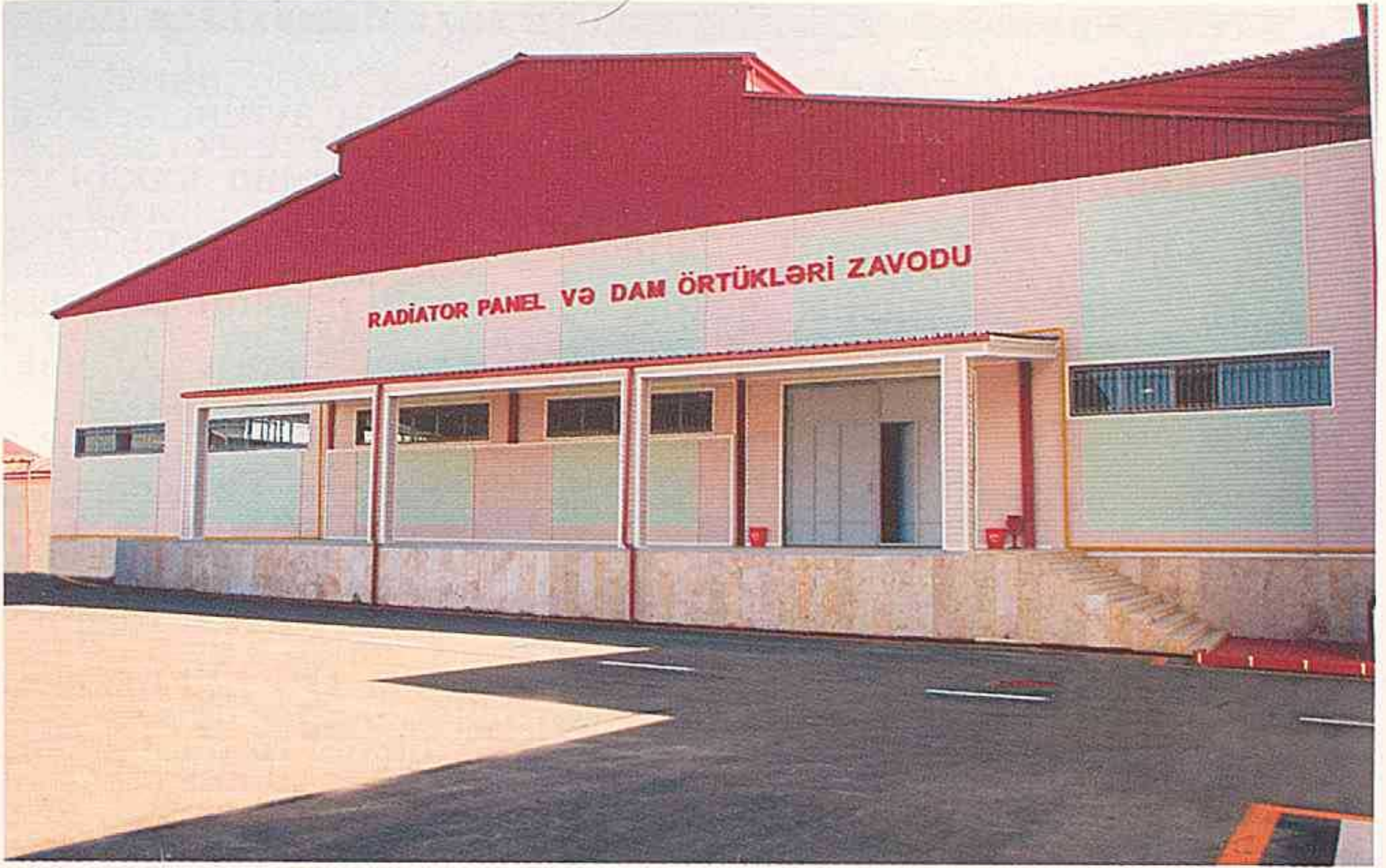
“Cahan Sənaye Kompleksi” ASC Radiator Panel və Dam Örtükləri Zavodu
