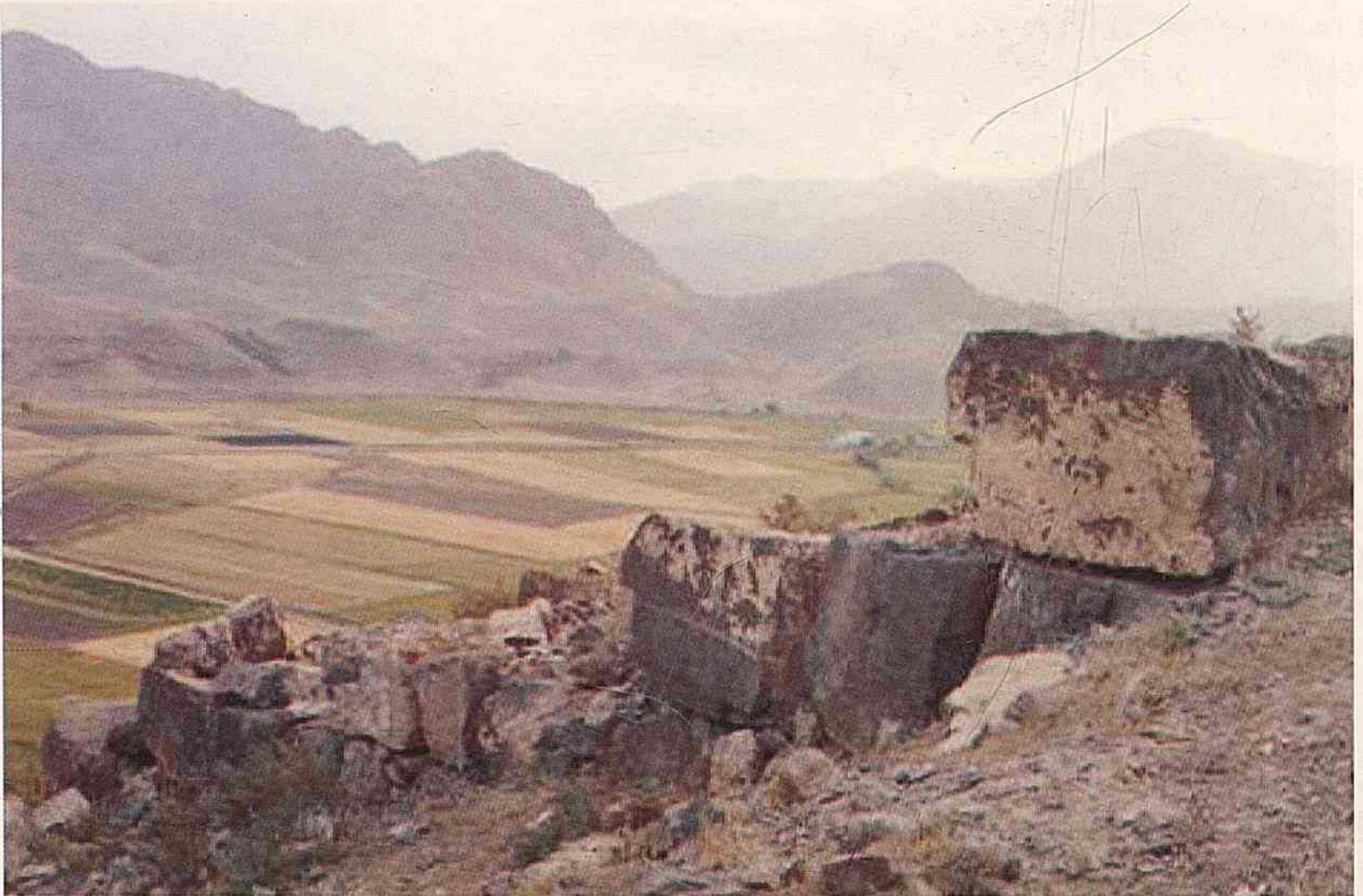
Şəkil 3. Oğlanqalada şimal-qərb müdafiə divarı. Figure 3. Northwestern fortification wall at Oğlanqala. Рис. 3. Северо-западная оборонительная стена в Оглангала.
