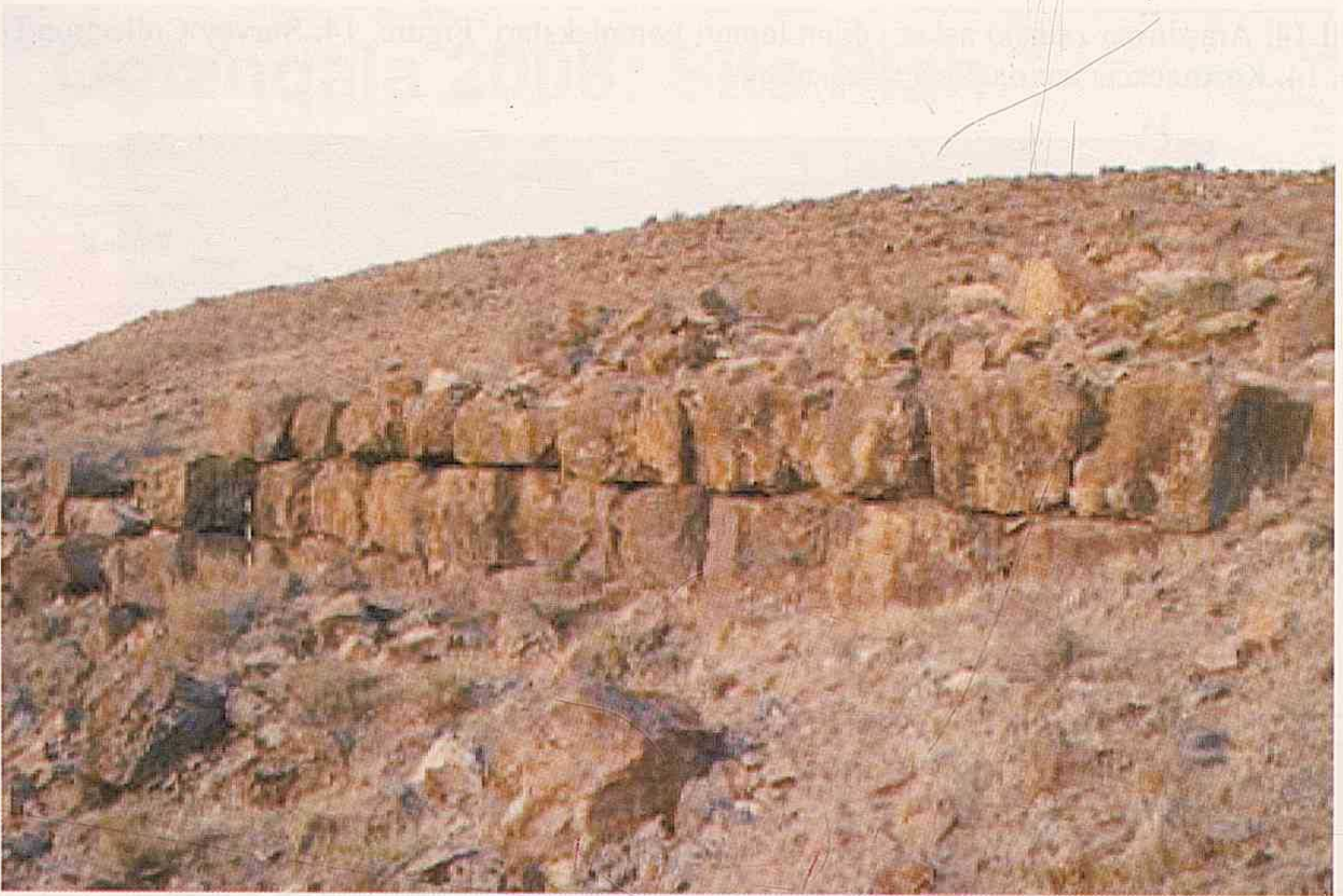
Şəkil 17. Oğlanqalanın cənub-şərqində müdafiə divarı, içəridəki evlərin sahəsində. Figure. 17. Outer fortification wall in Oğlanqala Southeast, an area of domestic houses. Рис. 17. Внешняя оборонительная стена на юго-востоке Оглангала, область внутренних зданий.
