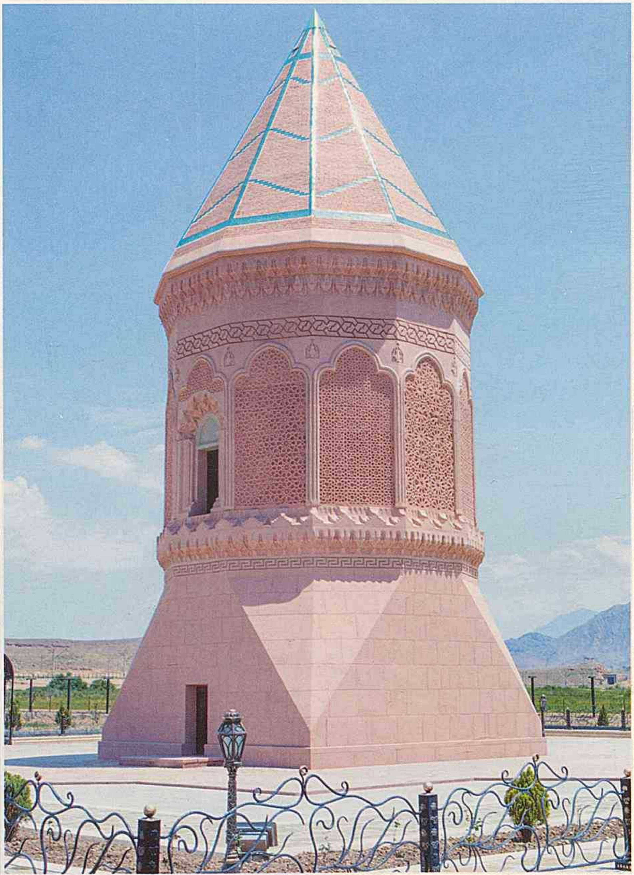
Güllüstan Türbəsi (Culfa rayonu)
