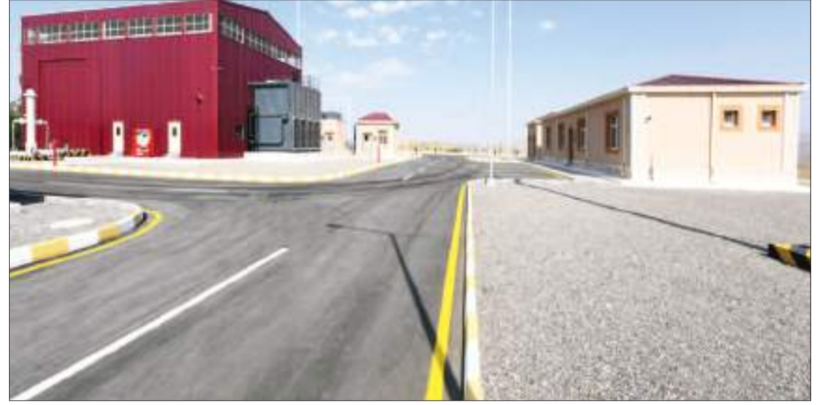
Naxçıvan şəhərində Qaz Kompresor Stansiyası
