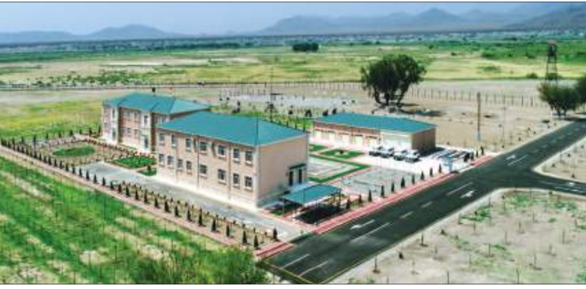
“Naxçıvan” Əlahiddə Sərhəd Döviziyasının 6-cı Sərhəd Zastavası üçün xidmət və yaşayış kompleksi
