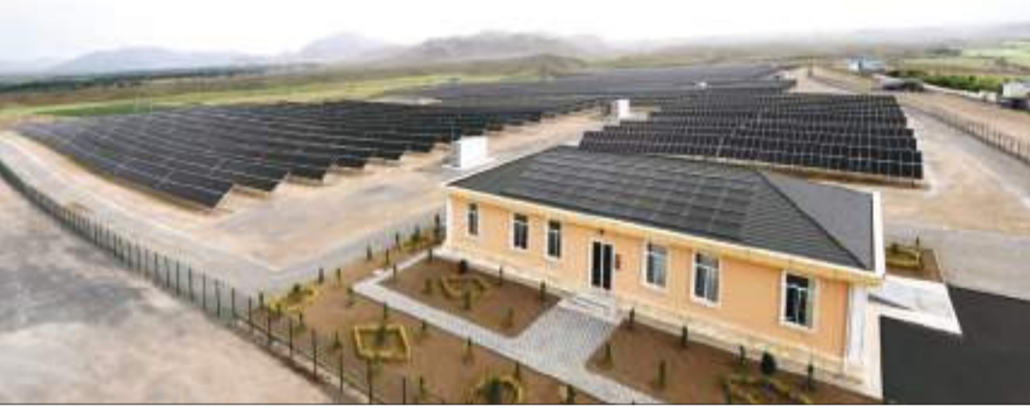
5 meqavat gücündə Şərur Günəş Elektrik Stansiyası
